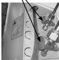
Bouchons des vannes d'isolation
