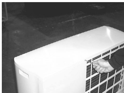
enlever la vis centrale (partie arrière)
