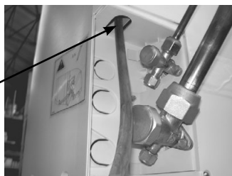
Détail pour l'alimentation du coffret électrique
